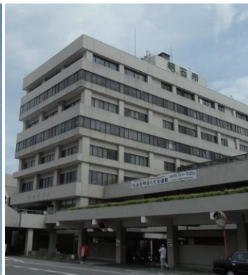
明石市役所本庁舎
