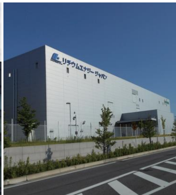
リチウムエナジージャパン栗東工場
