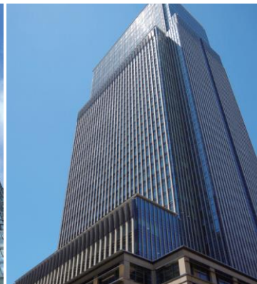
日本橋三井タワー
